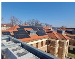
Probrat Kft. - Kistelek | 191,25 kWp
